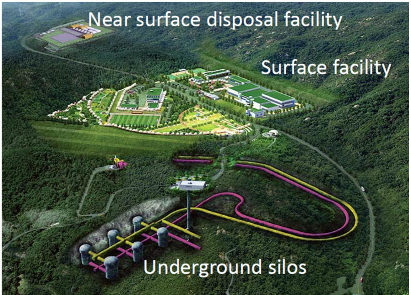
Im Jahr 2007 begann die KORAD mit der ersten Bauphase zur Errichtung von sechs unterirdischen Silos zur Endlagerung von LILW. Die Einlagerung wurde 2014 genehmigt und seit 2015 betrieben. In einer zweiten Bauphase sollen zusätzliche Anlagen zur
